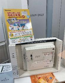
地震の際、停電から復旧したときに倒れた電気製品などから発火する恐れがあります。感震ブレーカーがあれば、震度5以上の地震が来たときに主幹ブレーカを強制遮断して電気をストップ。避難時にブレーカを切り忘れていても安心です。
