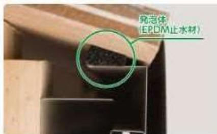
発泡体(EPDM止水材)を野地板に圧着させて取り付けることで、シーリングレスの省施工を実現。さらに、雨仕舞上の弱点を解決します。
